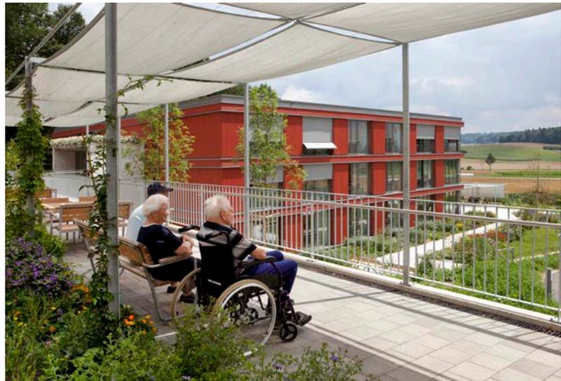
Grundlage bildet eine flexible und pragmatische Konstruktionskombination: massive Bauweise innen, leichte Bauweise aussen. Die Fassade ist mit einer rot lasierten Holzschalung verkleidet. Die Auszeichnung der Deckenstirnen ergibt eine Leichtigkeit des doch grossen Bauvolumens.
