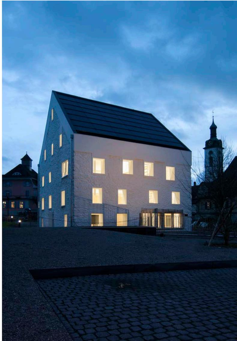
Der bestehende 400-jährige Bau wird bis auf die einzig noch brauchbaren Aussenwände aus Bruchstein zurückgebaut. Mit einem neuen massiven Dachrand aus Beton wird das Gebäude stabilisiert. Alt und neu werden mit Schlämmputz bearbeitet und unterstützen zusammen mit den tiefen Leibungen den kräftigen muralen Charakter.
